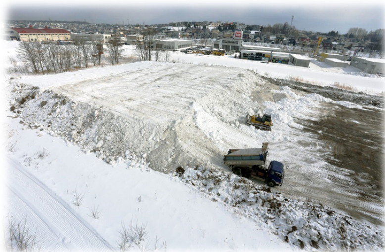
河川敷の雪堆積場
