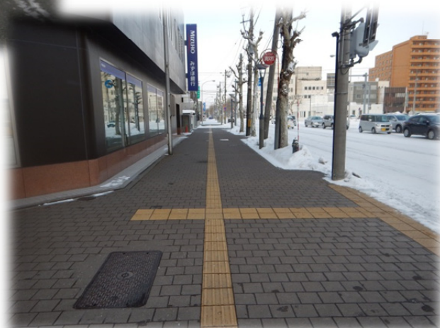
ロードヒーティング (歩道)
