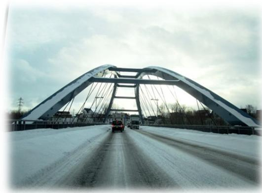
大正橋などのアーチ橋は、雪氷落下による事故防止のため、高所作業車で定期的に雪氷を除去している。
