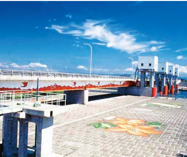
忠別川浄水場取水堰
