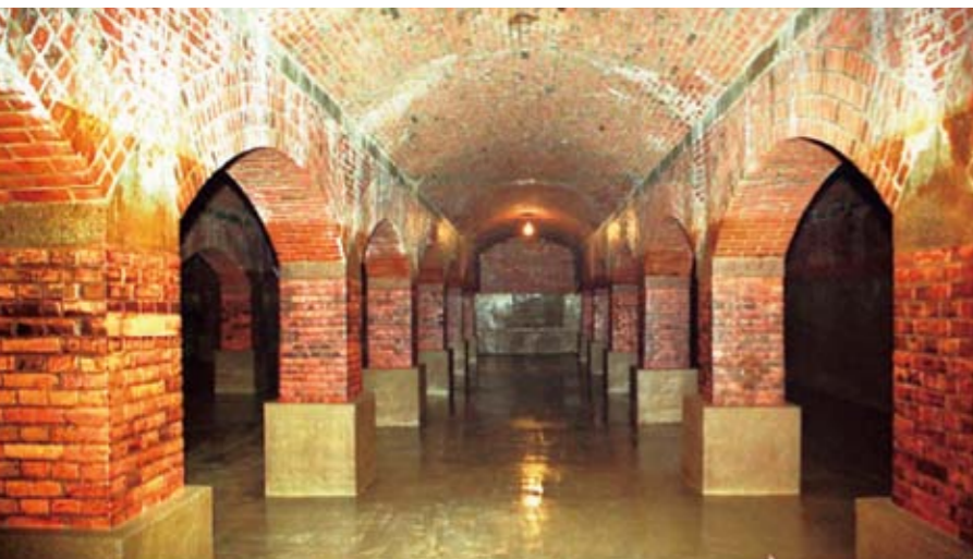
ふくがい 覆蓋付緩速ろ過池 (近代水道百選選定、土木学会選奨土木遺産認定の施設)
