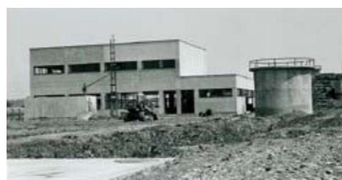
亀吉処理場建設時のポンプ室
