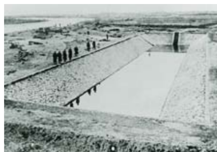
軍用水道 取水口沈砂溝 (現在の石狩川浄水場)
