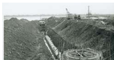
亀吉処理場建設時の放流管
