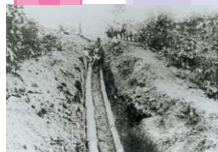
軍用水道の鉄管敷設 (右:揚水管 左:配水管)
