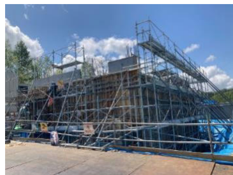
《建設中の新高砂台調整池》
