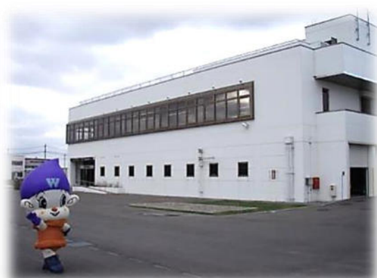
《忠別川浄水場》
