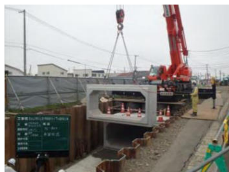
《雨水幹線の整備》
