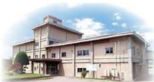
《亀吉雨水ポンプ場》
