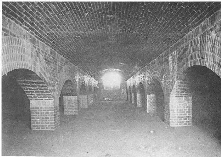
竣工後ノ濾過池
