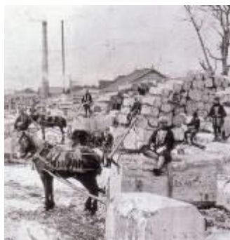
大正時代の製材現場
