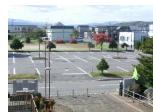
駐車場整備後
