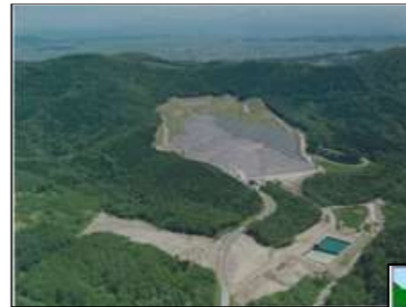
旭川市廃棄物処分場 (平成15年6月)
