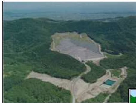
旭川市廃棄物処分場 (平成15年6月)
