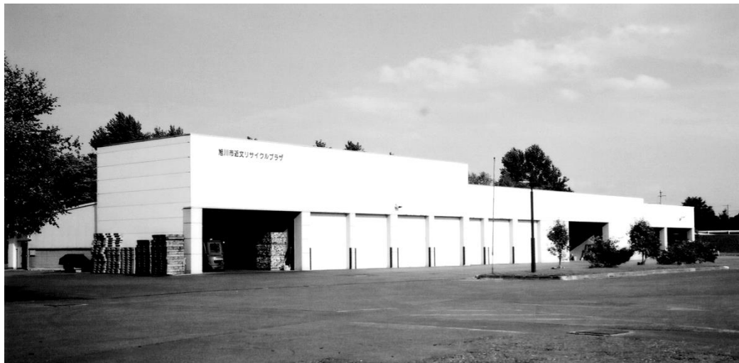
【近文リサイクルプラザ 工場棟】
