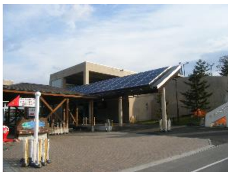
図 2-3 旭山動物園の太陽光パネル
