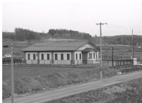
図 4-5 千代ヶ岡農業集落排水処理センター
