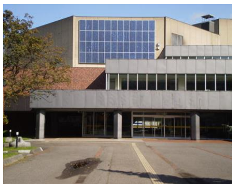
図 2-2 市民文化会館の太陽光パネル
