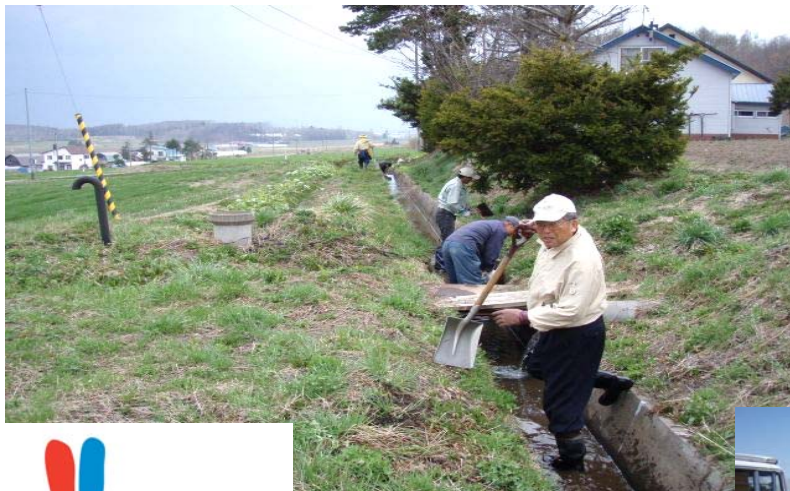
用水路泥上げ
