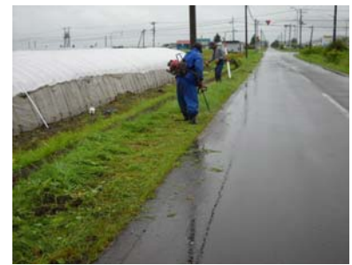
道路法面の草刈
