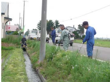
道路法面の草刈
