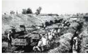
▲牛朱別川切替工事の作業風景
