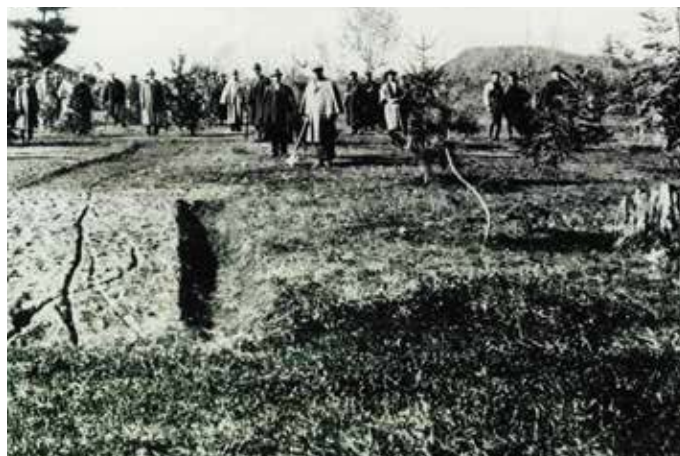
▲造成中の常盤公園を視察する旭川町議会メンバーら。まず池と築山が作られその後、植樹が行われた。写真の背後にはすでに築山が見えている
