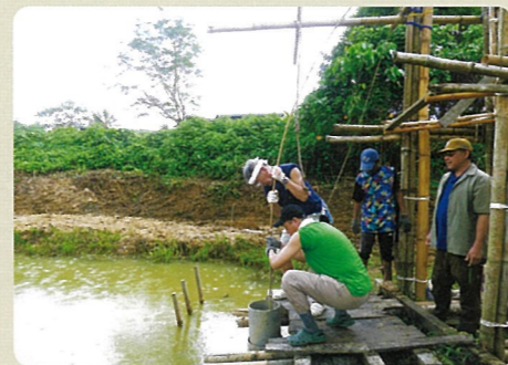
「かずさ掘り」で井戸を掘っています
