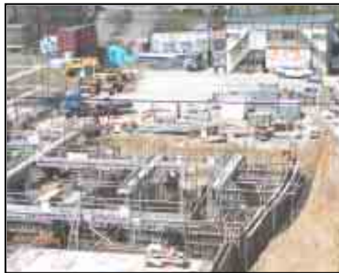
工事現場のようすです
