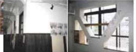
銅駝美術工芸高等学校:外観保持等のため、事業者提案に基づき内部補強
