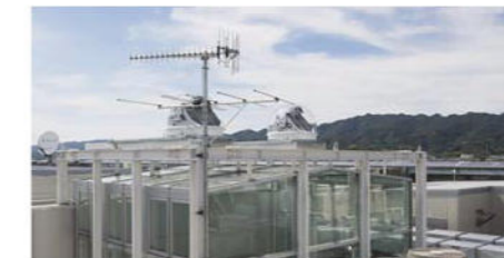
建物内部に自然光を導く集光器設置の事例
