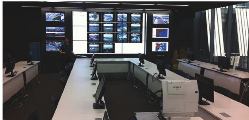
事例（長岡市庁舎）
