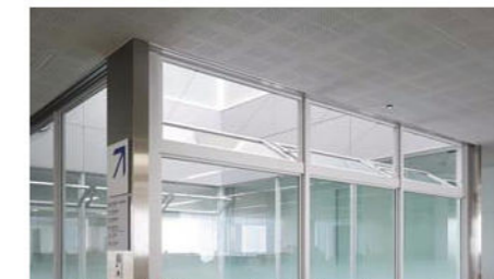
自然光を取り込み・自然換気できる光庭の事例
