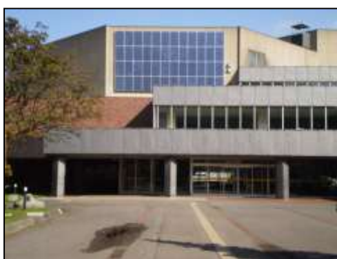
【旭川市民文化会館の太陽光パネル】
