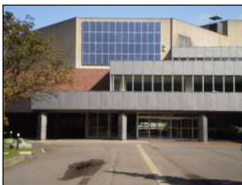
【旭川市民文化会館の太陽光パネル】
