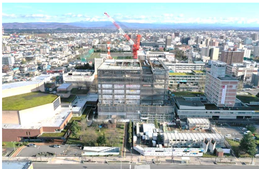
▲上空から撮影した新庁舎（R3年11月撮影）
