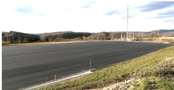
▲ (6) 駐車場舗装工事
