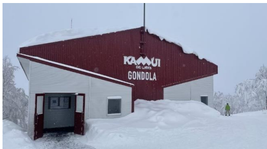
▲ (5) ゴンドラ駅舎外部改修
