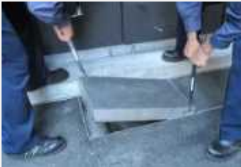
ケーブルピット-1
