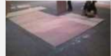
車両設置物 養生方法 ビニールシート・コンパネ・ パンチカーペット
