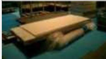
仮置き場 養生方法 ビニールシート・Pボード3mm
