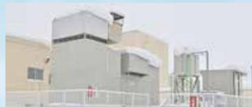
平成30年の北海道胆振東部地震では、停電で浄水場の設備が停止。配水池の水を供給し、事なきを得ましたが、対策として2つの浄水場に発電機を導入しました。万一に備え、ご家庭でも水の備蓄をお勧めします。
