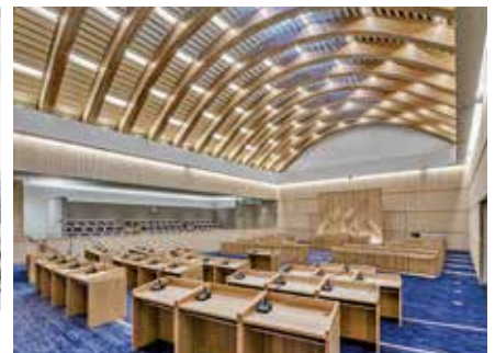
はり梁・壁などに市有林材を使った8階の議場
