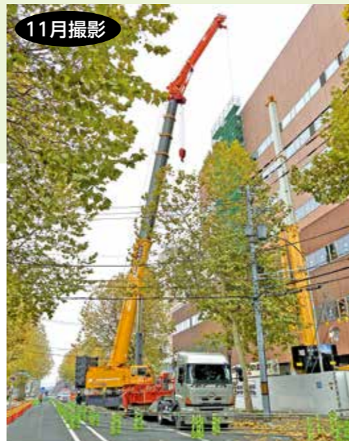
解体作業用クレーンの組み立てと撤去は、交通に支障のない夜間に行いました
