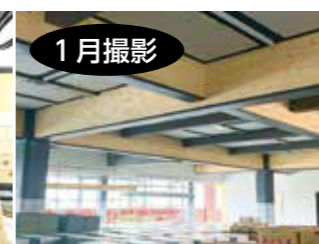
2階天井の梁にトドマツ材を張りました。1階・2階・9階の天井や議場の壁・天井には、旭川市有林から伐採した木材を使っています
