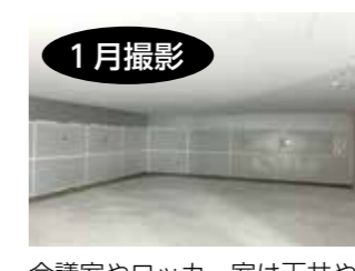
会議室やロッカー室は天井や壁の張り付け作業が終わり、空間の様子が見えるようになってきました
