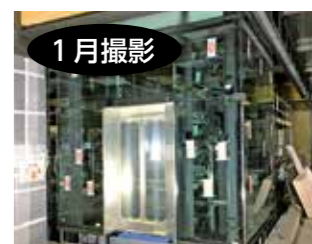
1階・2階の吹き抜けに設置する、低層用エレベーターを取り付けています
