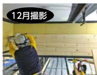
2階天井の梁にトドマツ材を張りました。1階・2階・9階の天井や議場の壁・天井には、旭川市有林から伐採した木材を使っています
