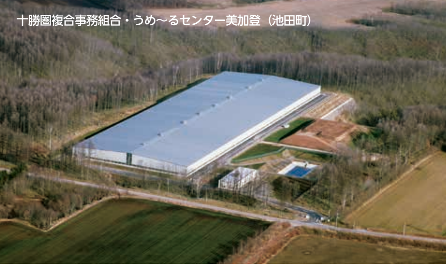
覆蓋型処分場の外観。市では、敷地面積40,000㎡（スタルヒン球場1.6個分）、埋立容量161,000㎡の覆蓋型処分場を想定
