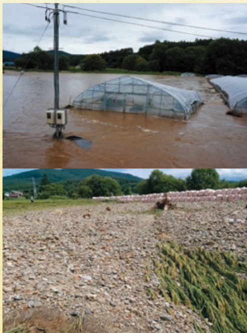
ペーパン川決壊による被害（東旭川町米原）
